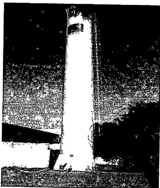
Reservatório elevado Sta.Casa
