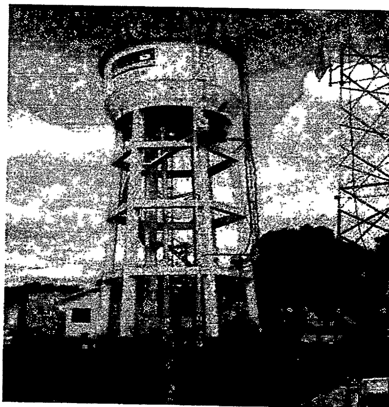
Vista do reservatório elevado.
