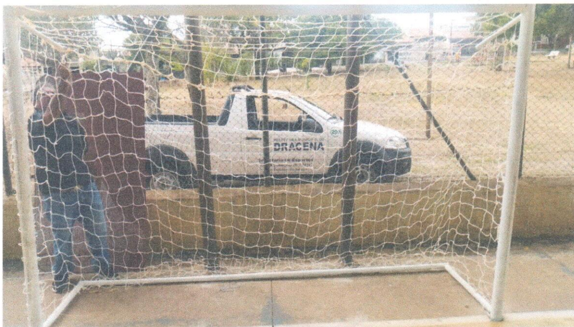
Traves Instaladas na EMEFI Otília Braz Nogueirol.
